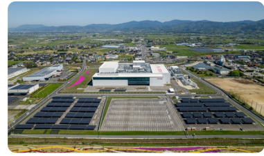
福岡久留米工場の太陽光パネル
