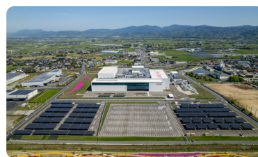
福岡久留米工場の太陽光パネル
