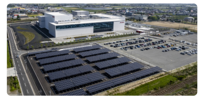
福岡久留米工場の太陽光パネル
