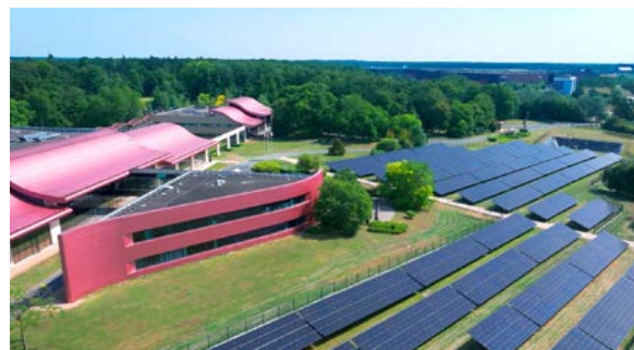
フランスのバル・ド・ロワール工場に設置された太陽光パネル
