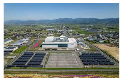
福岡久留米工場の太陽光パネル
