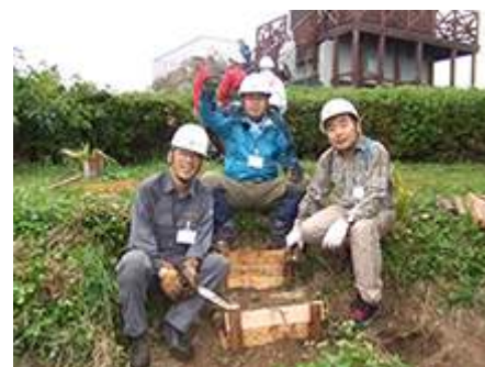
崩れていた階段を整備
