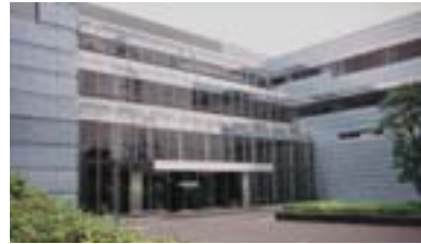
外部サッシ複層ガラス
