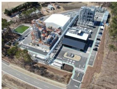
住友化学は、環境に配慮したエタノールを原料とするエチレンの試験製造設備を2022年4月に千葉工場(千葉県市原市)に新設しました。商業化に向けて、研究開発や工業化技術のノウハウを生かし、エタノールを原料に、従来と同等の品質を持つポリオレフィンの製造に取り組めます。さらに、リサイクル技術を活用して得られるプラスチック製品の独自ブランド「Meguri<sup>®</sup>」の普及などを通じて、さまざまなステークホルダーと共に循環型社会の実現に貢献してまいります。
